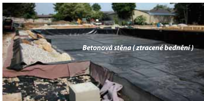
Betonová stěna (ztracené bednění)
